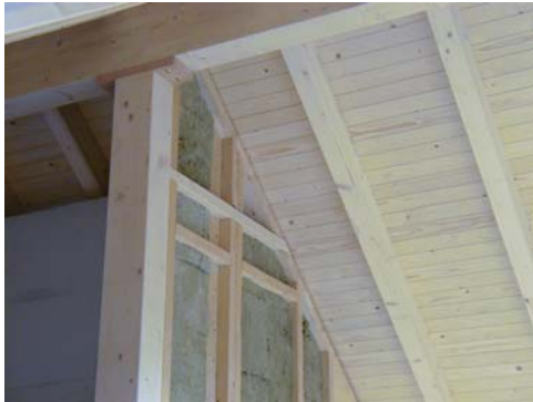
(Innenwand gedämmt mit Dachanschluss)
