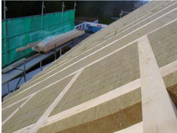
( Dachisolierung mit Lattung )
