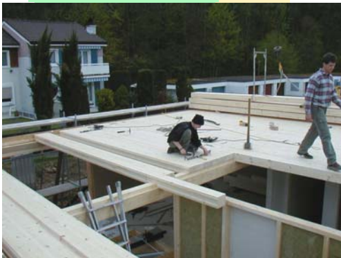
( Brettschichtholzboden die Alternative zur Betondecke )
